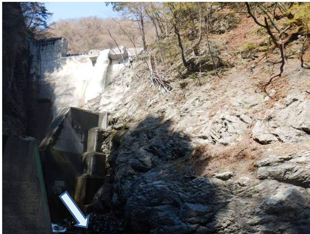
下流より左岸側を望む
