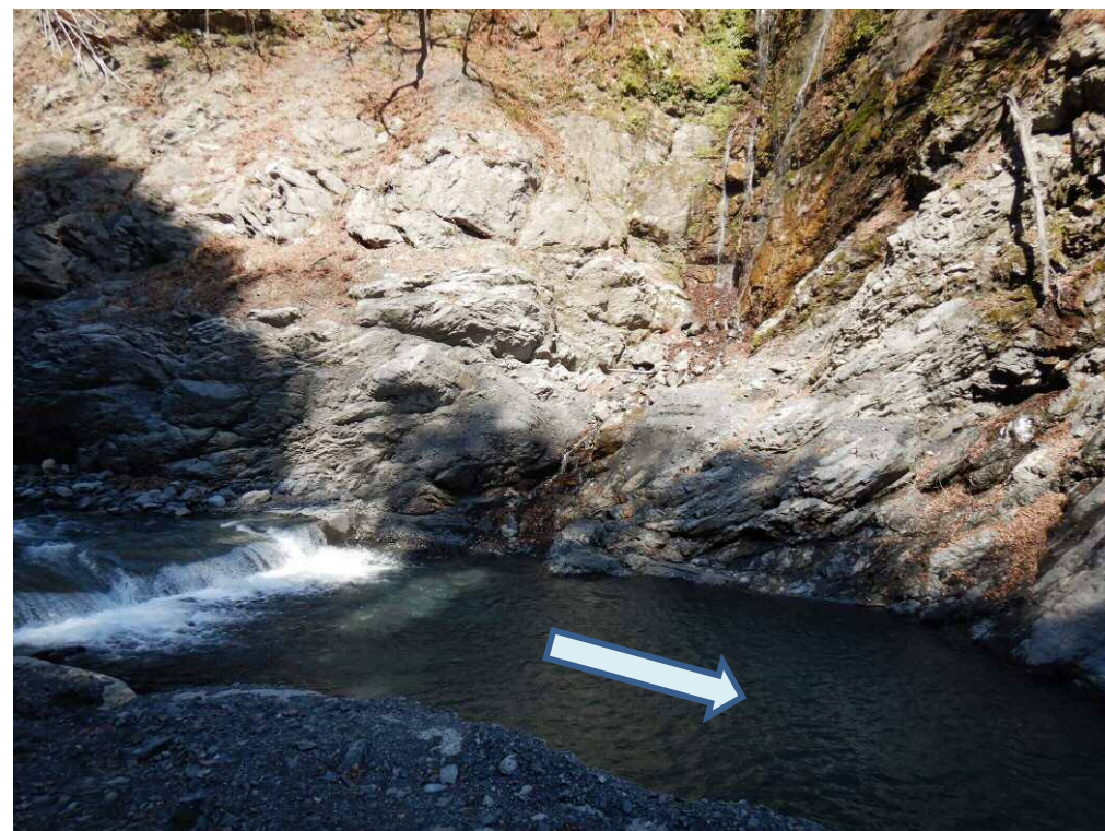
水叩き施工箇所付近
