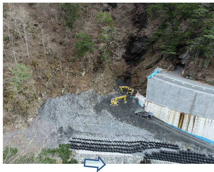
【右岸側より施工箇所を望む】
