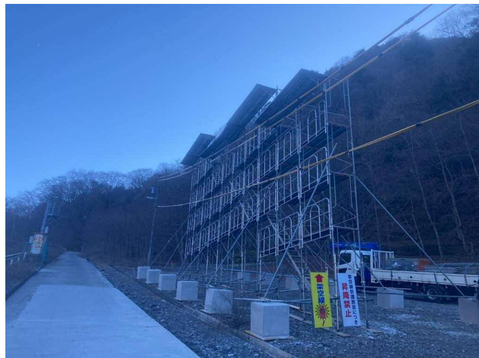
仮設工架空線防護施設完了
