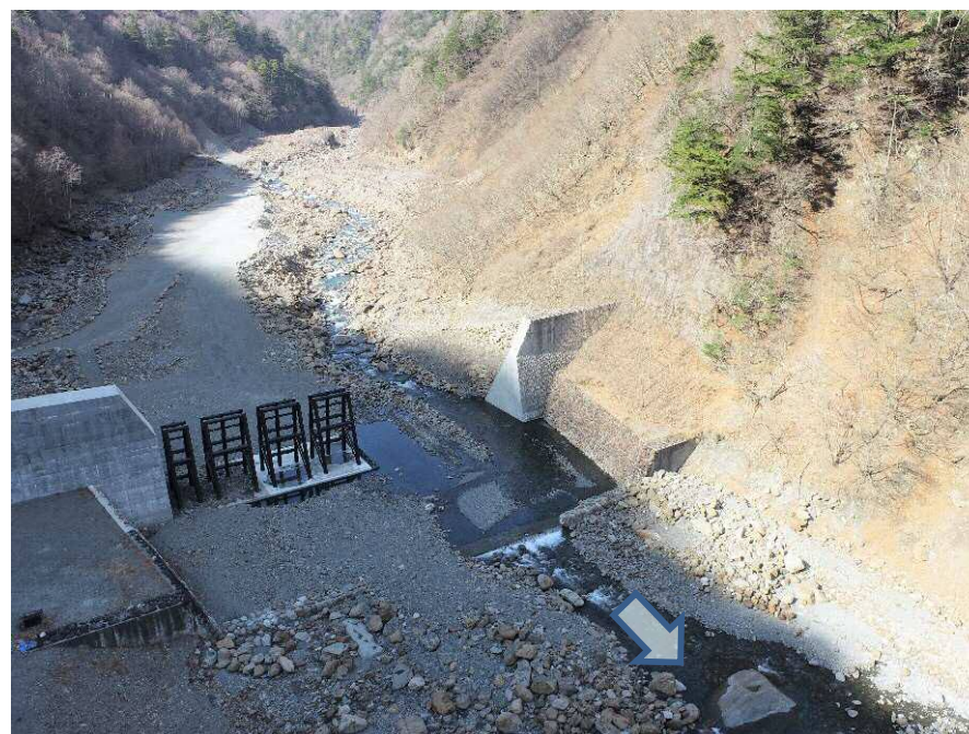
【下流側より施工箇所を望む】
