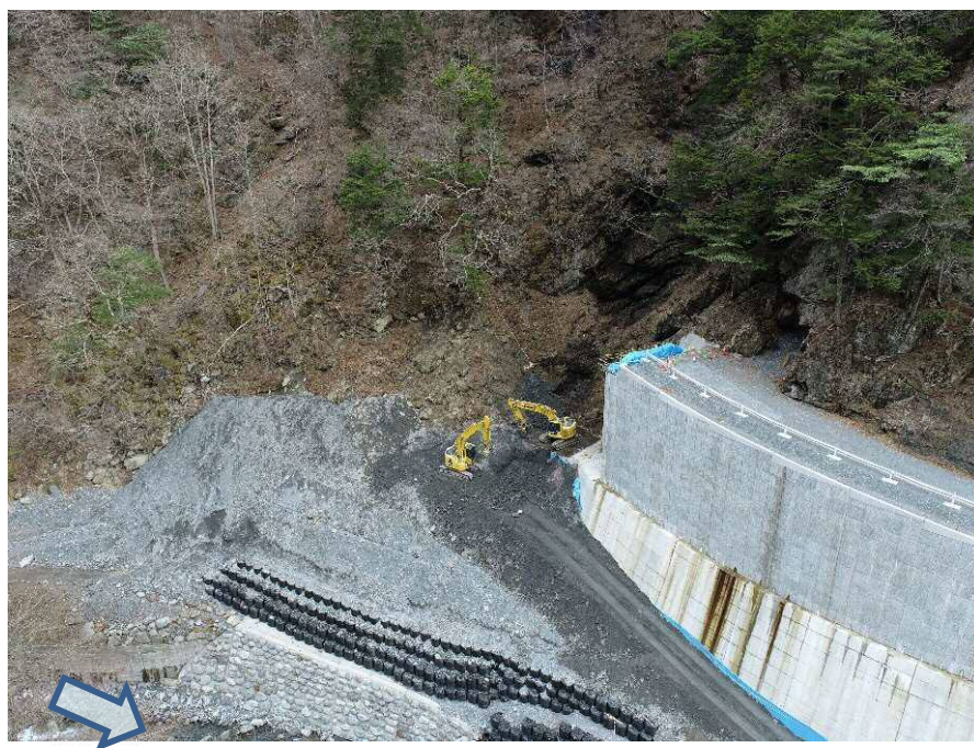
【下流側より施工箇所を望む】
