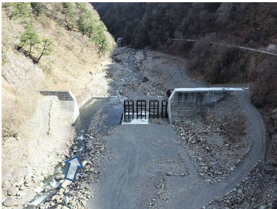
【上流側より施工箇所を望む】
