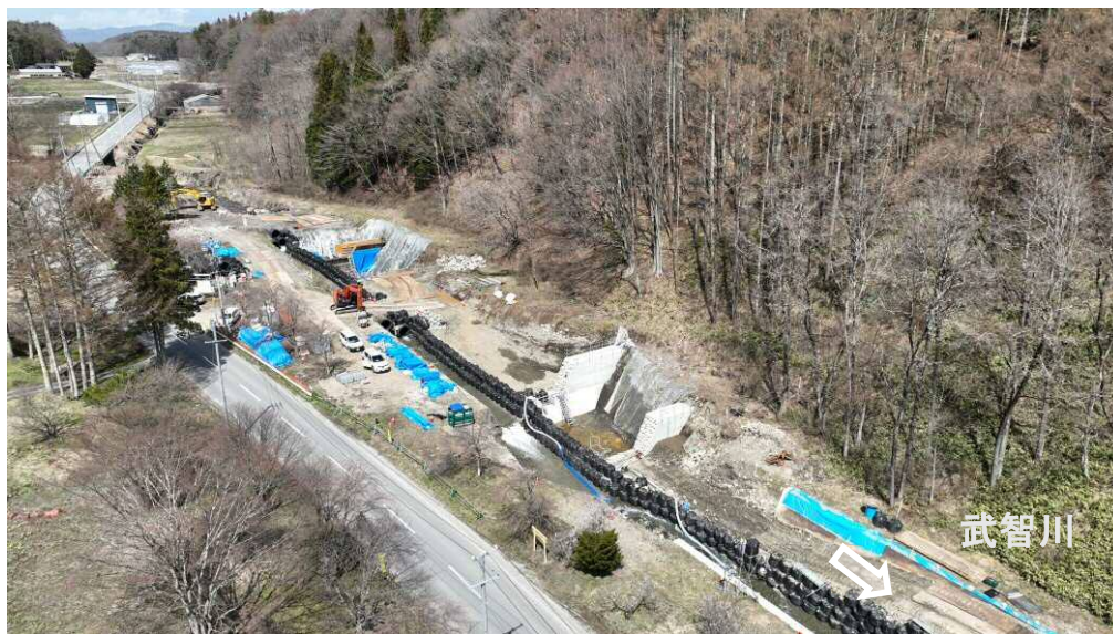
下流上空より施工箇所を望む
