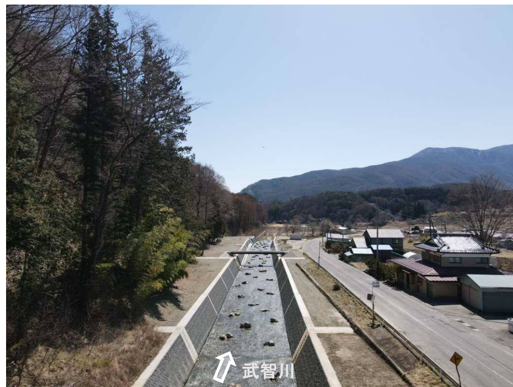
【完成】上流上空より 施工箇所（全景）を望む
