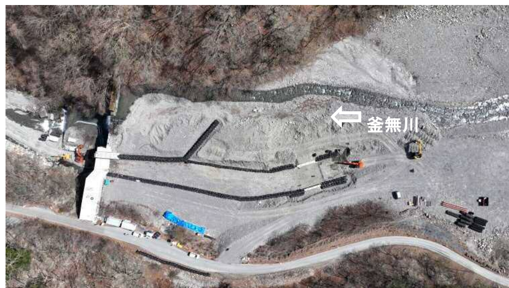
上空より本堰堤上流側を望む
