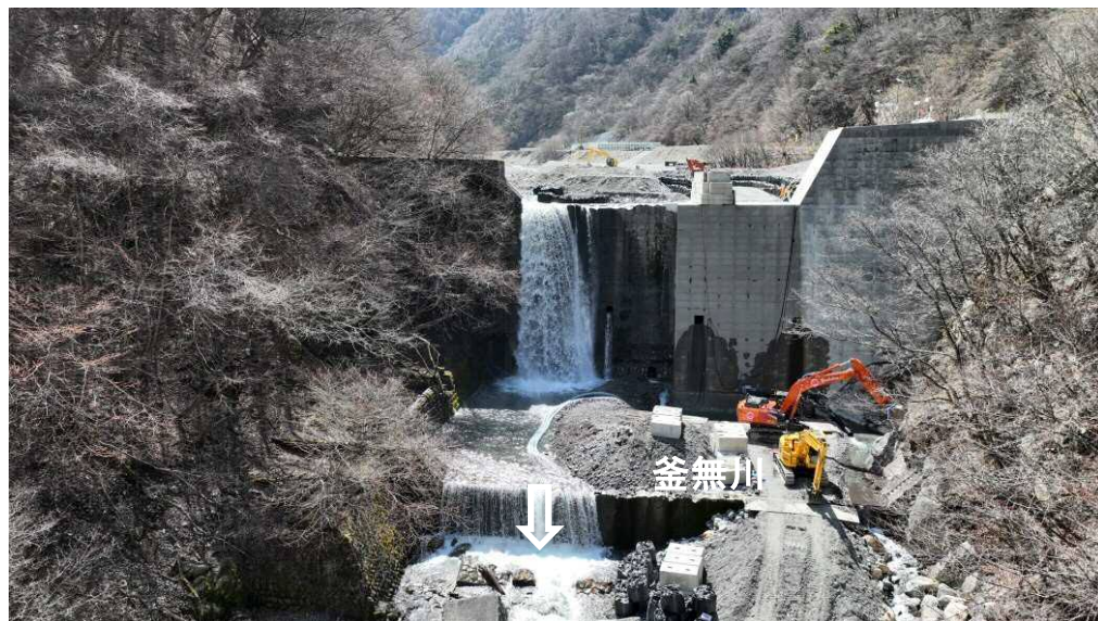
下流より本堰堤を望む
