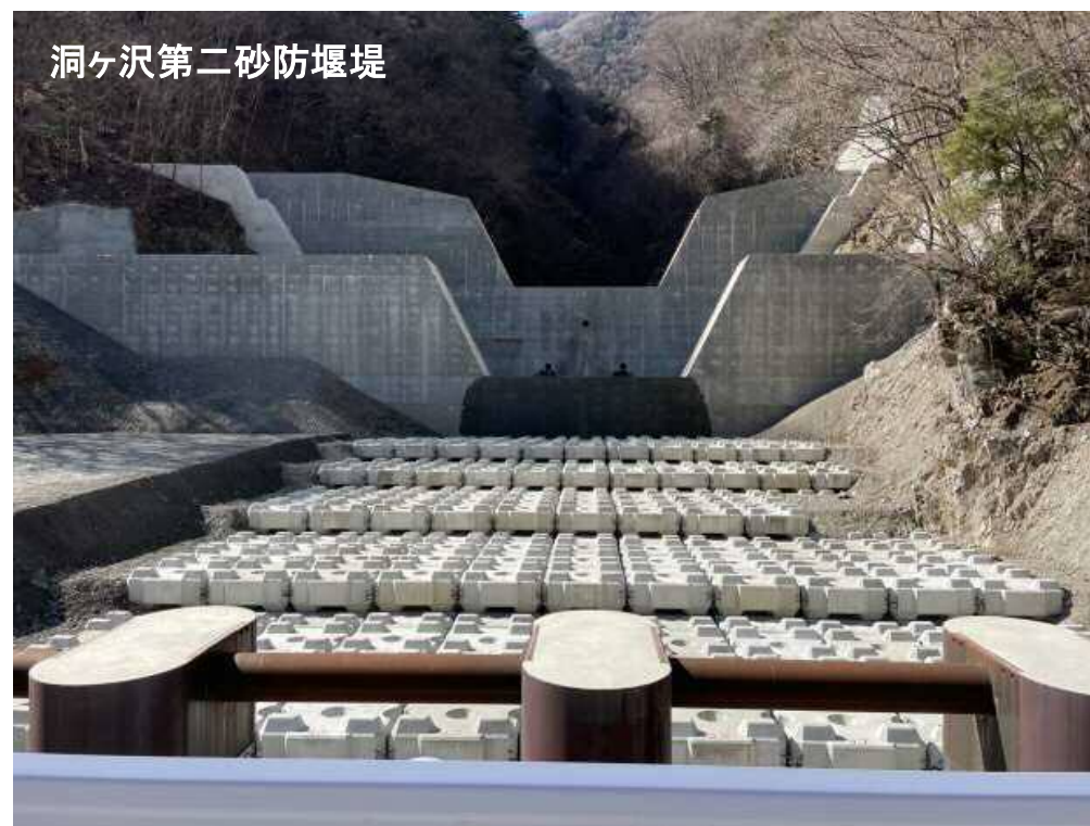
【完成】下流より護床工・根固工 施工箇所を望む
