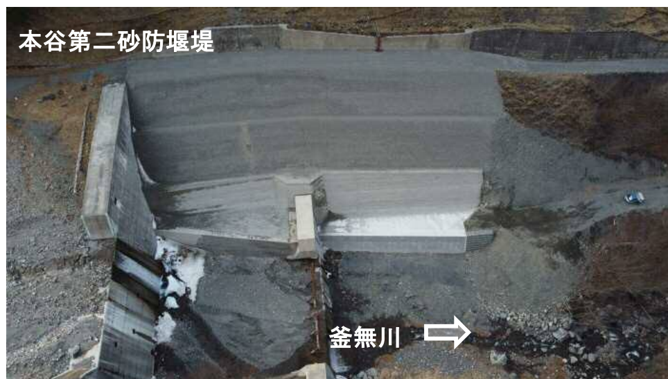
【完成】施工箇所を望む（A地区）
