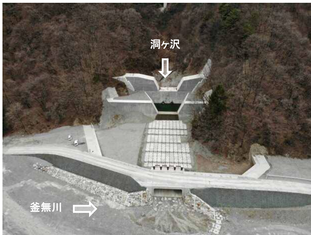
【完成】下流上空より 施工箇所（全景）を望む
