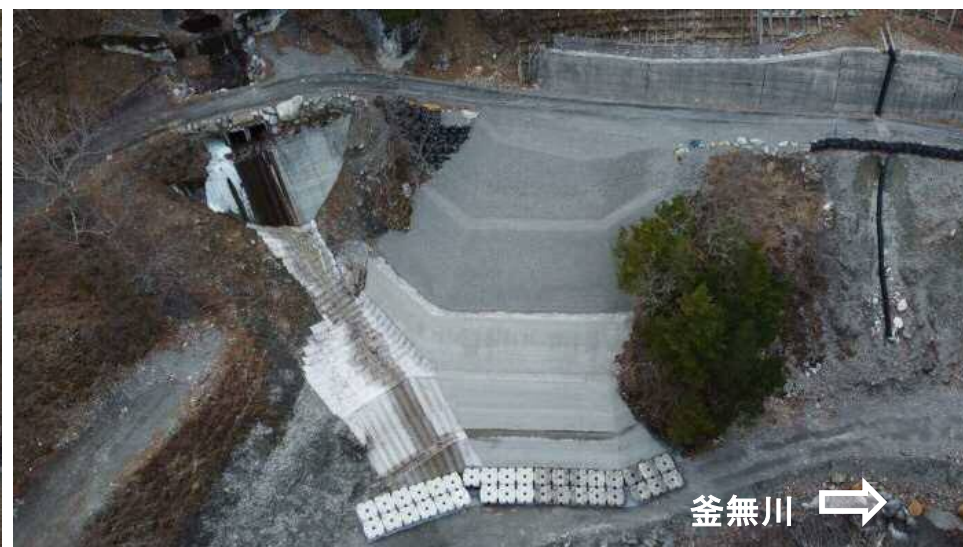
【完成】施工箇所を望む（I地区：中島砂防堰堤下流）
