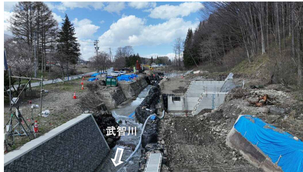
下流より施工箇所を望む
