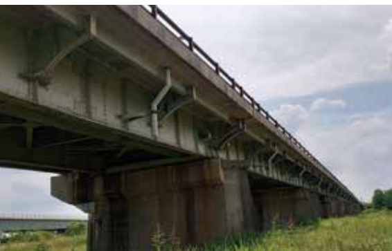
令和4年 (旧)神流川橋の様子
