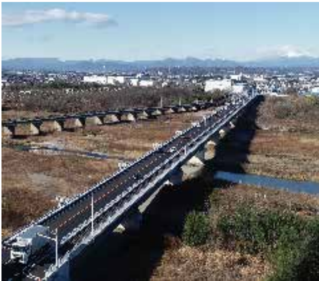
神流川橋架替区間整備状況
