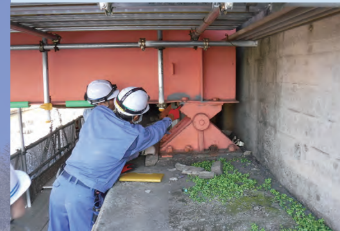
直轄国道の橋梁の調査 / (東京都)
