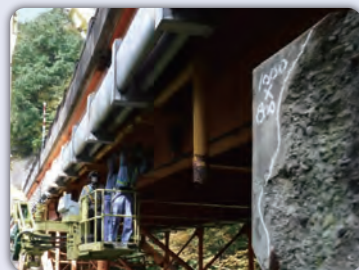
橋梁等の健全性の診断
