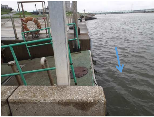
11. 小松川緊急用船着場
