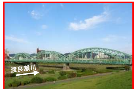
橋梁架替(中橋)
