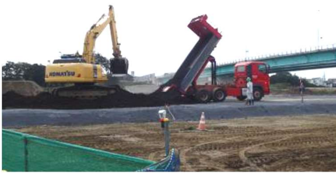
盛土工事状況
