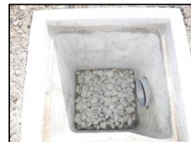
雨水貯留浸透枡整備事例(昭和町)
