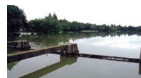
27_松伏調節池(洪水 時)_近景.jpg
