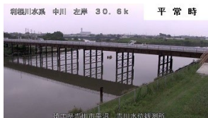
01_吉川水位観測所_平常時.jpg
