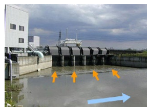
15_首都圏外郭放水路_倉松川流入部.jpg
