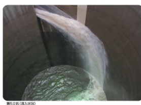
18_首都圏外郭放水路_ 第5杭_流入.jpg
