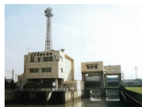
21_伝右川排水機場.jpg
