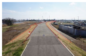
02_堤防整備(後).jpg
