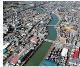
11_河道改修_後.jpg
