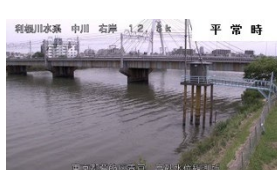
09_高砂水位観測所_平常時.jpg
