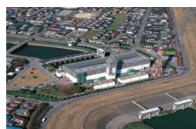
22_三郷排水機場+三 郷放水路.jpg
