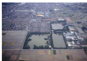
26_松伏調節池(洪水 時).jpg
