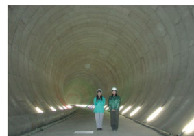
16_首都圏外郭放水路_トンネル.jpg
