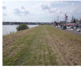
07_堤防嵩上げ(後).jpg
