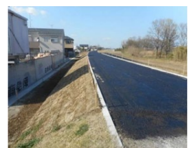
04_堤防整備(後).jpg
