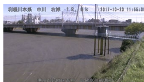
10_高砂水位観測所_増水.jpg
