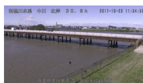
02_吉川水位観測所_増水.jpg
