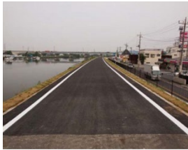
09_堤防嵩上げ(後).jpg
