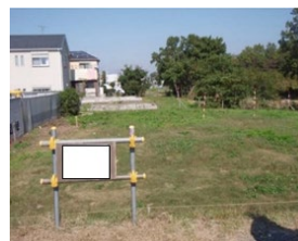
03_堤防整備(前).jpg
