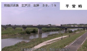
13_野田水位観測所_平常時.jpg
