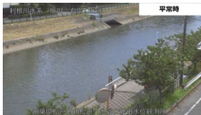
17_坂川_大谷口新田水位観測所_平常時.jpg
