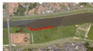
07_河道掘削(後)▼.jpg
