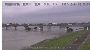
14_野田水位観測所_増水.jpg
