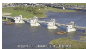
05_H29_写真_01.jpg
