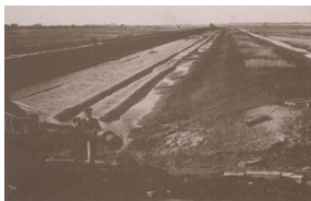
09_江戸川放水路の開 削.jpg
