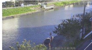
18_坂川_大谷口新田水位観測所_増水.jpg
