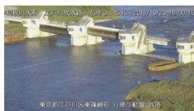
06_H29_写真_02.jpg
