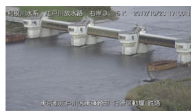
07_H29_写真_03.jpg
