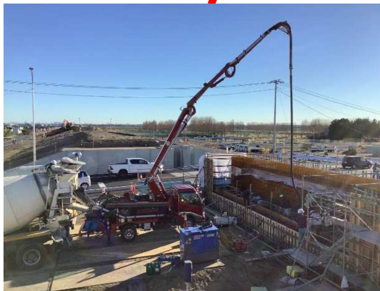
ゲート格納スペースコンクリー打設
