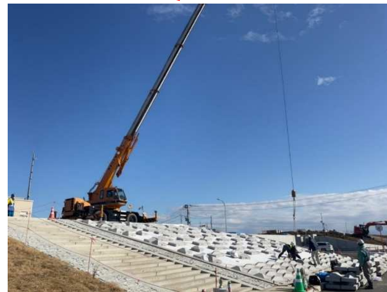
大型連節ブロック設置
