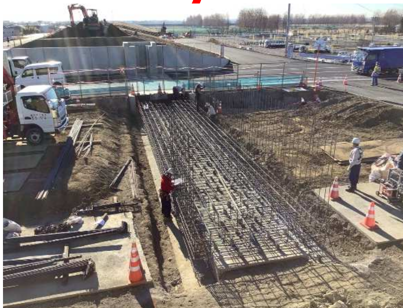
ゲート格納スペース施工
