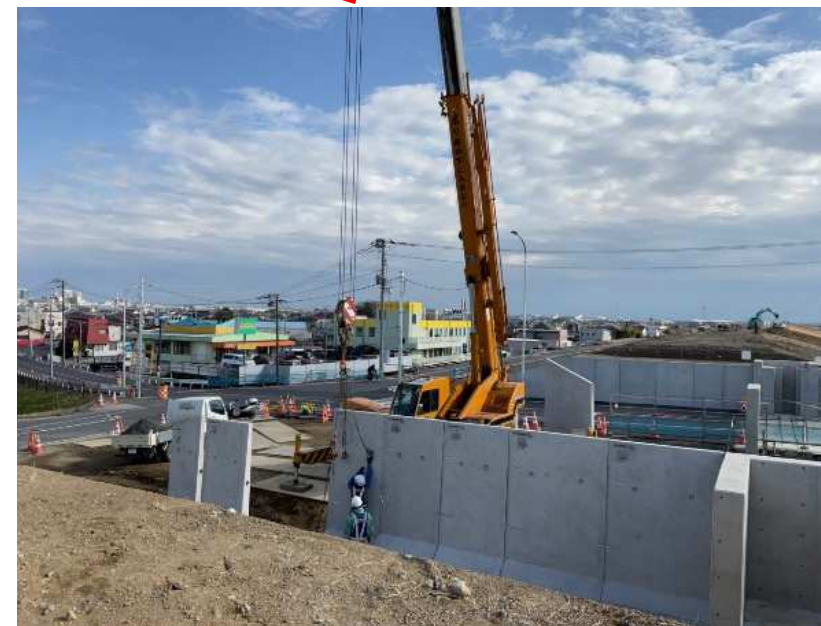
L型擁壁設置
