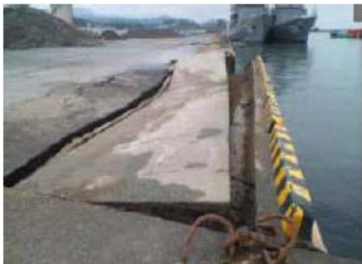
岸壁の破損
