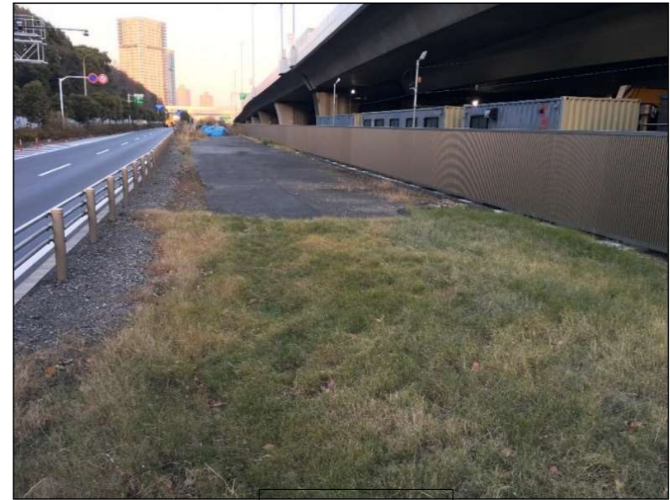
YP3橋脚~YA1橋台
