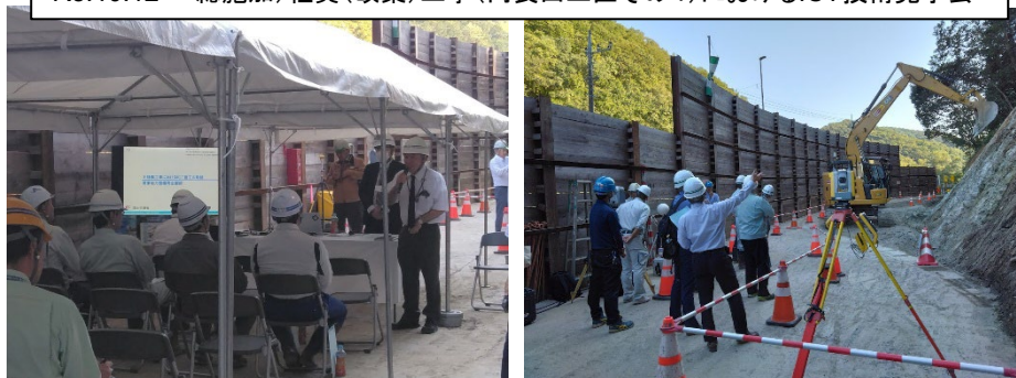
R5.10.12 総施加)社資(改築)工事(円良田工区その4)におけるICT技術見学会
