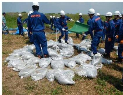
漏水防止工法(釜段工)の訓練状況
