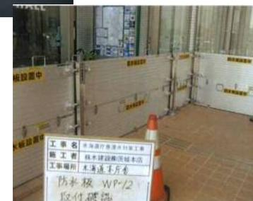
庁舎の周囲に整備された浸水防止板の様子(常総市)
