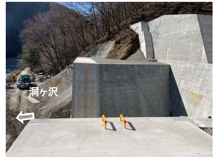
左岸より右岸を望む→
