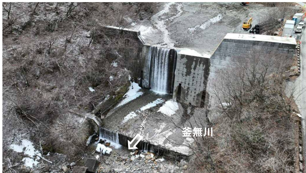
【着手前】下流より本堰堤を望む（コンクリート堰堤工）
