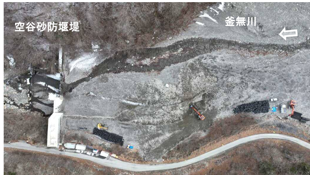
上空より本堰堤工を望む
