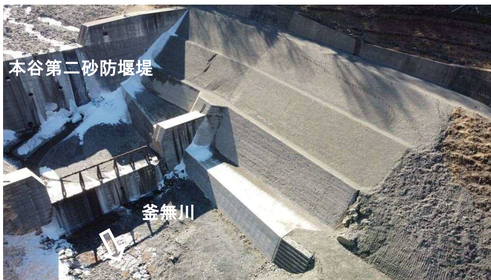
上空より施工箇所を望む（A地区）
