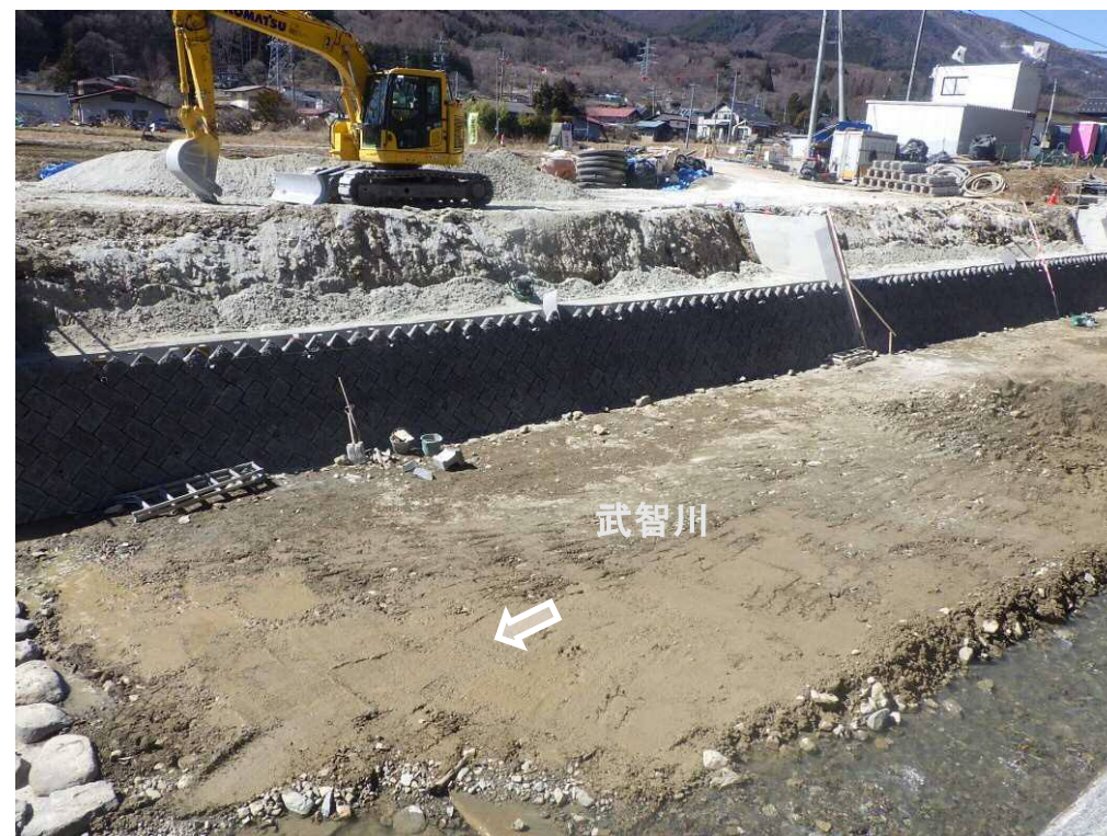
下流左岸より流路護岸工 ブロック積擁壁工 施工箇所を望む
