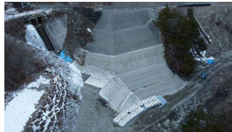
↑ 上空より施工箇所を望む（I地区：中島砂防堰堤下流）
