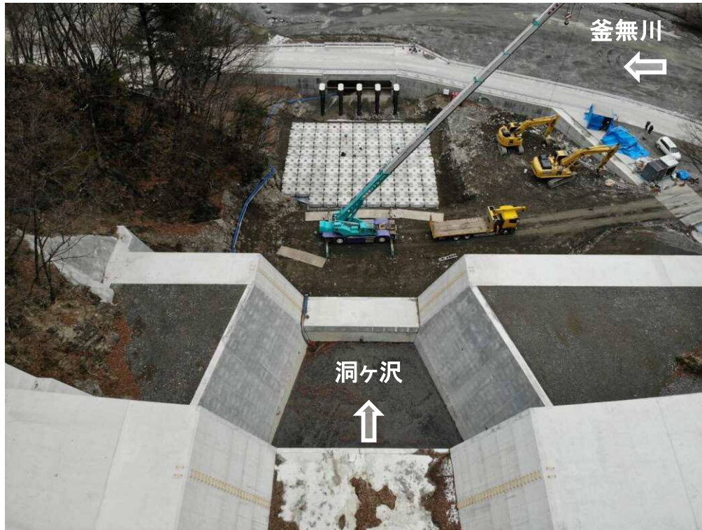
上流上空より施工箇所を望む
