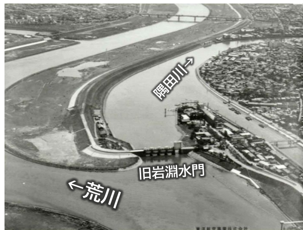
旧岩淵水門完成後の状況
