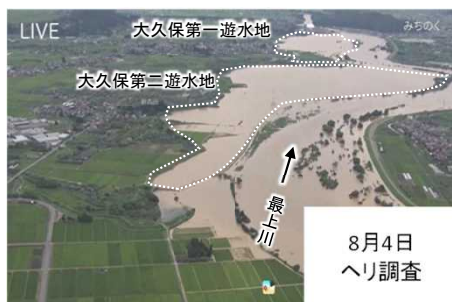
【遊水地への湛水状況(令和4年8月4日)】
