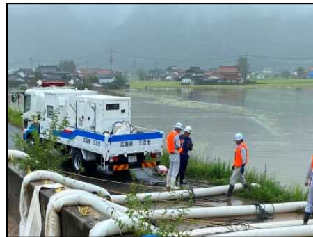
排水施設の整備
