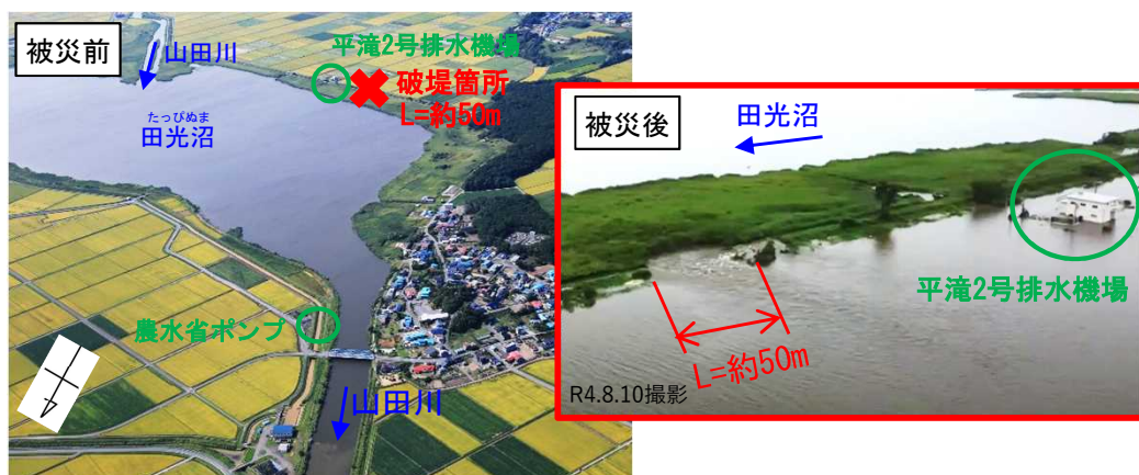
令和4年8月3日から大雨等による被害（青森県山田川）
