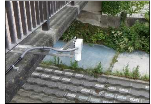
水位計の整備、改良
