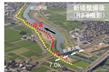
引堤(石川県梯川水系梯川)
