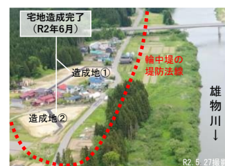
移転先宅地完成完了状況
