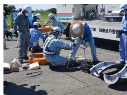
ポンプの組立
