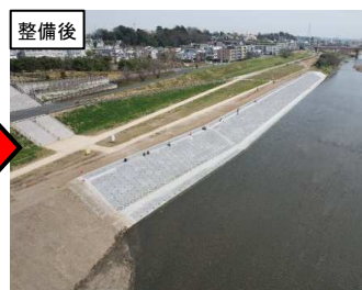
多摩川左岸17.0k付近(令和4年3月完成)
