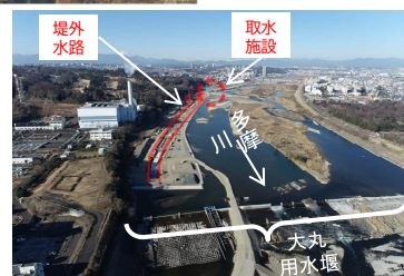
大丸用水堰改築工事状況(令和5年1月現在)
