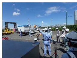
排水ポンプ車講習状況
