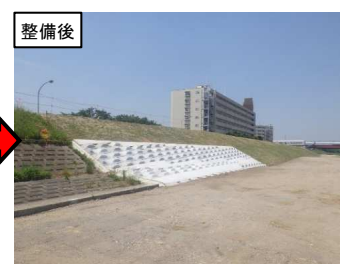
多摩川右岸20.2k付近(平成30年5月完成)
