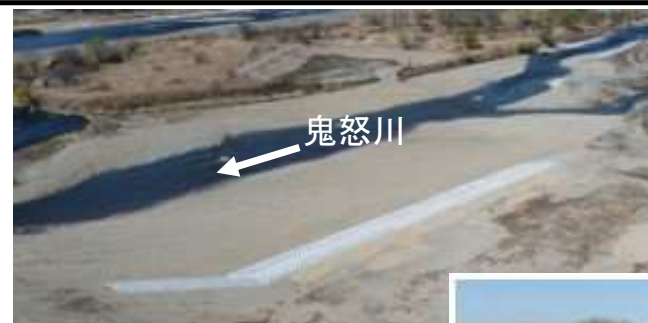
低水護岸（140m）の整備状況 （栃木県真岡市下籠谷地先）
