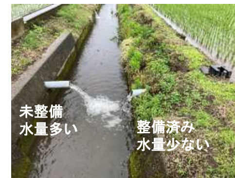
田んぼダムの整備状況 （上三川町大字石田地内）
