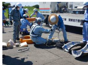
ポンプの組立
