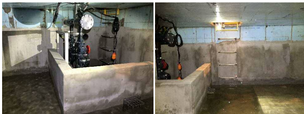
地下貯留施設
