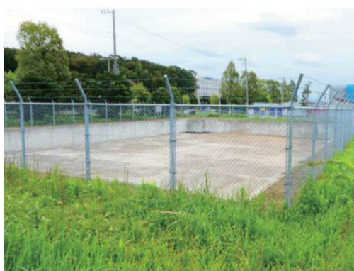
地表面貯留施設
