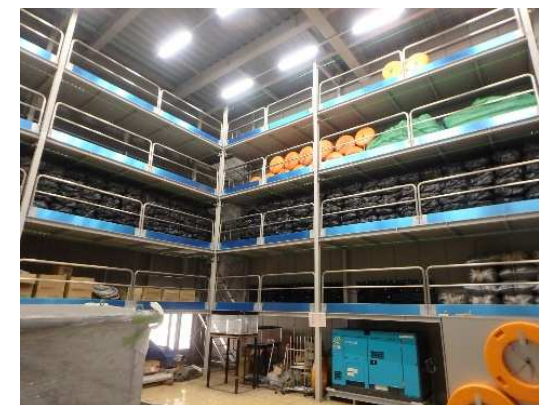
大師河原防災ステーション (京浜河川事務所)
