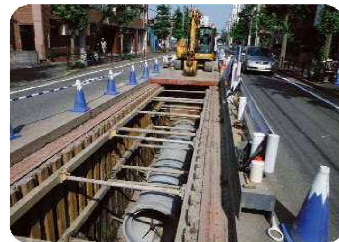
雨水管布設工事の状況
