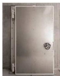
防水扉の設置
