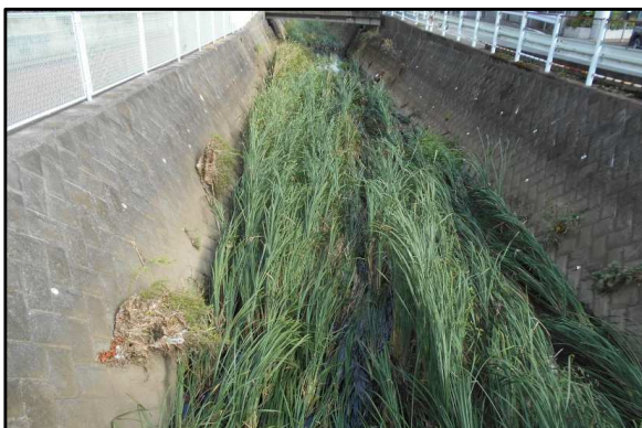
樹木伐採施工前（例 一級河川 砂田川）
