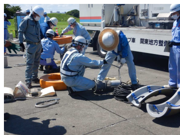
ポンプの組立
