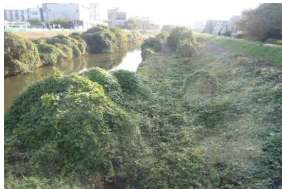
土砂撤去施工前（例 一級河川 矢上川）
