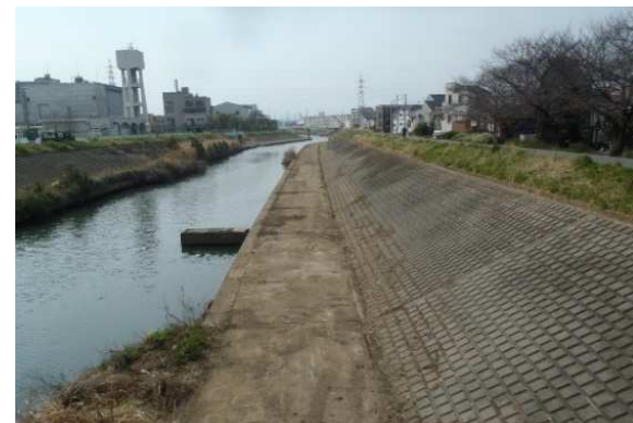
土砂撤去施工後（例 一級河川 矢上川）
