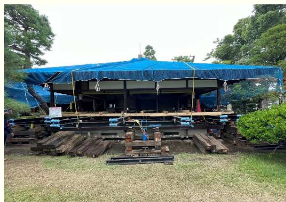
ジャッキアップ開始から 2日目朝撮影 14cmまで上昇
