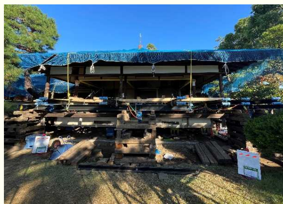
ジャッキアップ開始から 5日目朝撮影 75cmまで上昇
