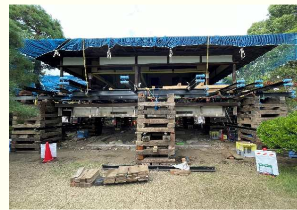
ジャッキアップ開始から 6日目午後撮影 目標の150cmまで上昇完了
