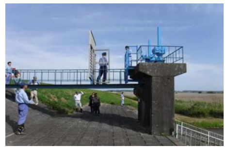
▲許可工作物（樋管）の履行検査状況
