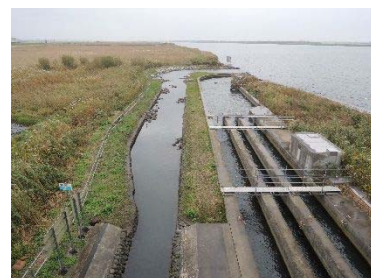
▲利根川河口堰緩傾斜魚道
