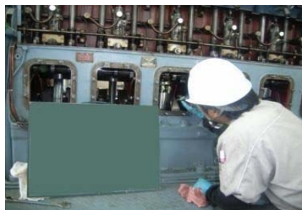
▲排水機場の機械点検作業
