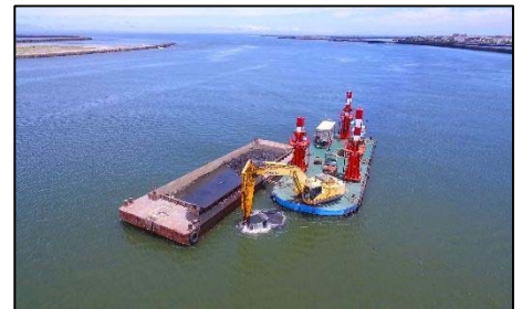
▲河道掘削の様子
