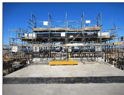
③芦崎排水樋管 (利根かもめ大橋下流右岸)
