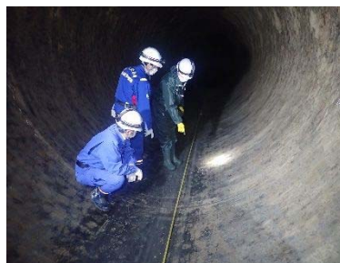
▲北千葉導水路の点検状況
