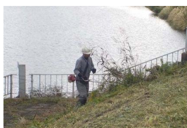
▲肩掛け式による堤防除草作業
