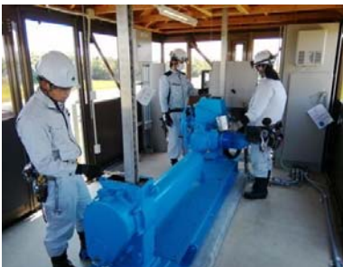
▲ゲート巻き上げの点検作業
