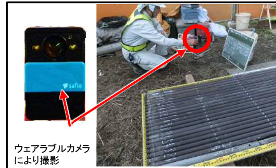
現場での受注者による検尺の撮影
