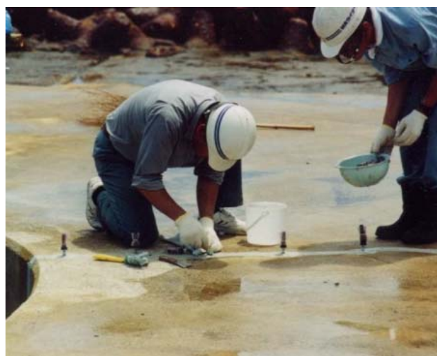
コンクリート護岸ひび割れ補修
