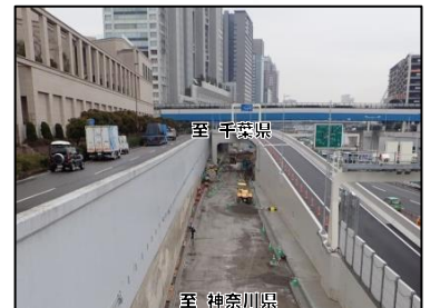
写真②: 台場側一般部施工状況
