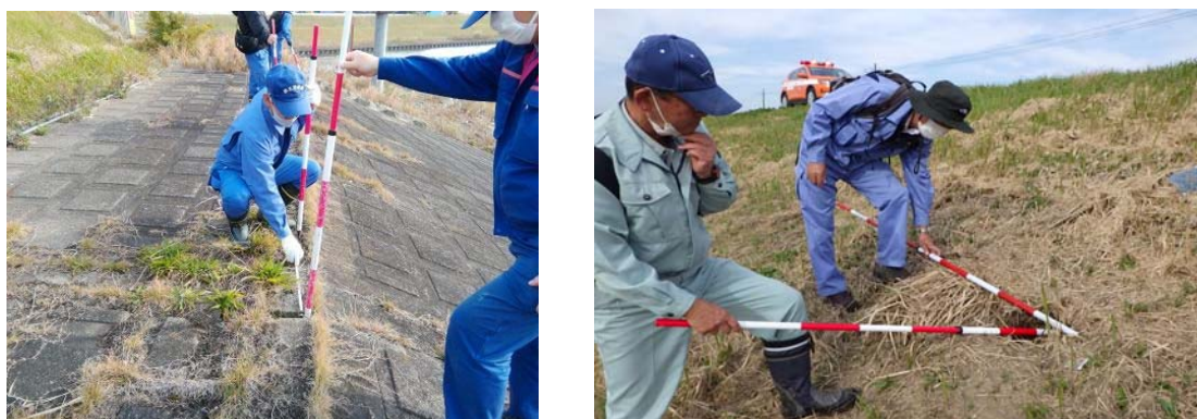
写真 5-4 堤防点検の様子
