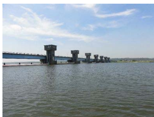
写真 1-6 利根川河口堰
