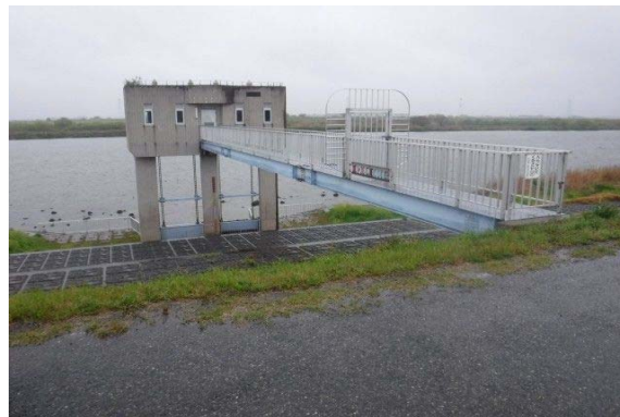
写真 3-4 蒲唐排水樋管
