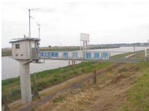
写真 5-1 布川観測所（水位・流量・水質観測）
