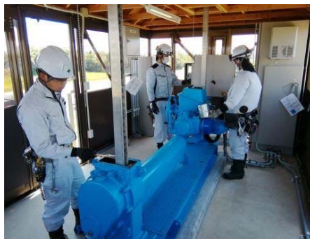
写真 5-5 機械点検の様子
