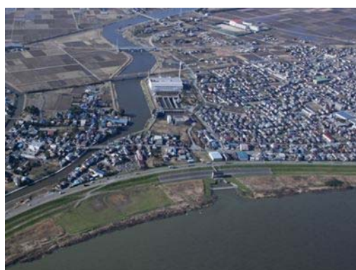
写真 1-7 北千葉導水路 第一機場
