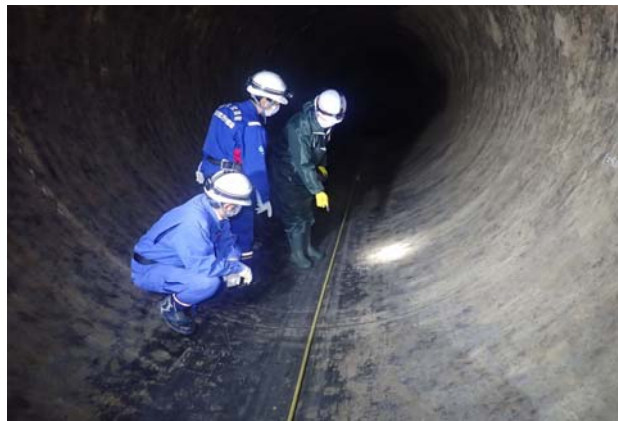
写真 6-6 北千葉導水路の点検状況
