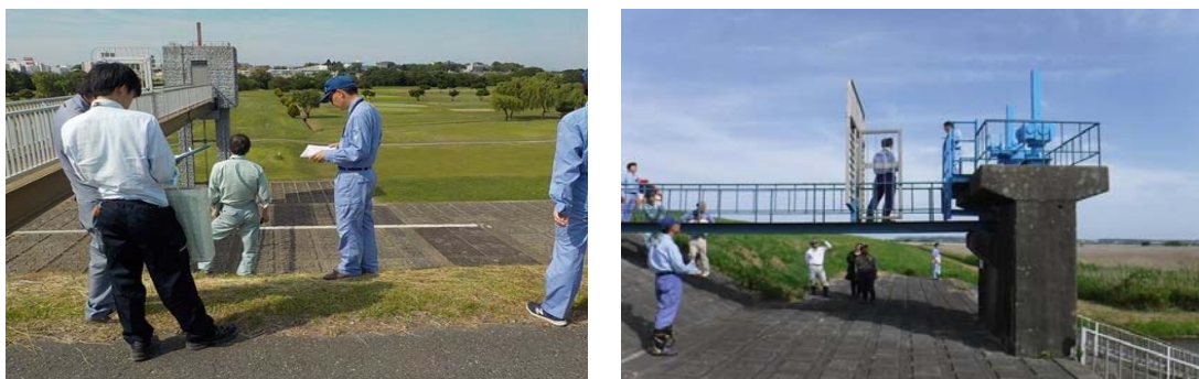
写真 5-6 許可工作物の点検の様子
