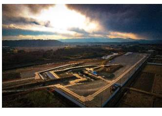
【日暮れの高畑樋管～上空より～】 岩田地崎建設(株) 石川 秀樹
