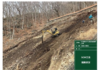
【高所無人掘削】 日特建設(株) 日特建設(株)
