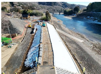
【吸出し防止シート敷設完了】 (有)飛田組 寺門 豊
