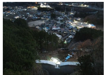
【暮らしを守る砂防堰堤】 中村土建(株) 田原 丈司
