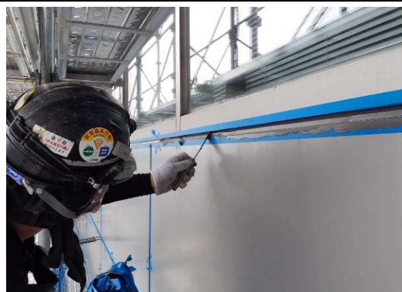
シーリングの施工状況
