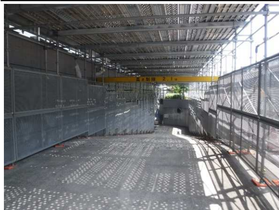
施設を使用しながらの足場設置
