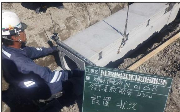
曲線部のU型側溝の場合、製品長が2m・4mの製品の場合はU型側溝にプリズムを設置して丁張レスで施工した方が早い場合もある。
