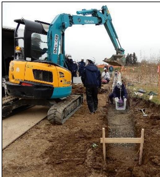
今回の工事では直線部分が多く、U型側溝は製品長60cmの製品を使用しているため、丁張を設置してU型側溝布設を実施した方が施工時間が早く、出来栄も良好である。
