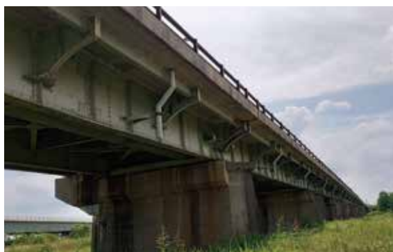
令和4年（旧）神流川橋の様子
