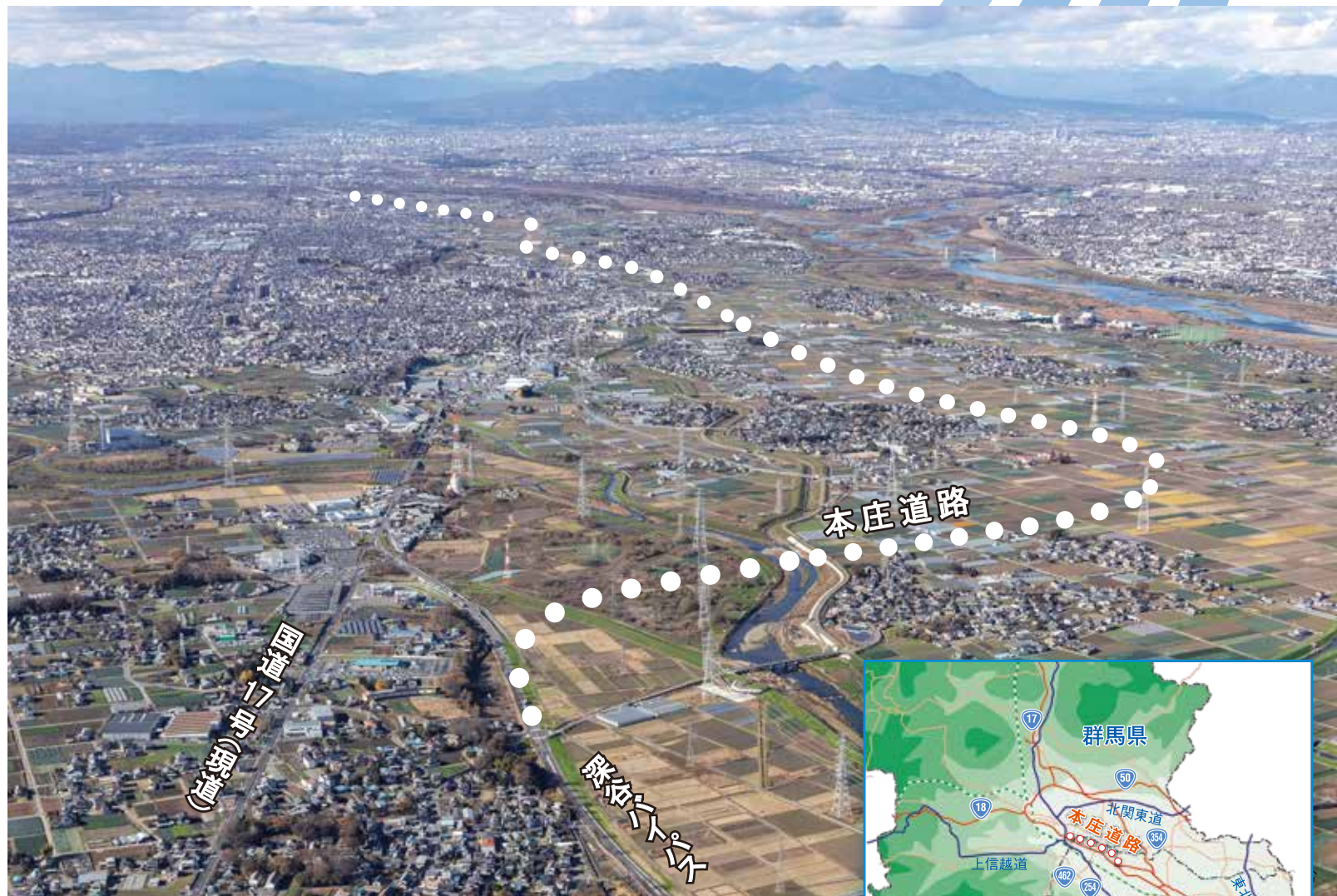
起点側より群馬県方面を望む
