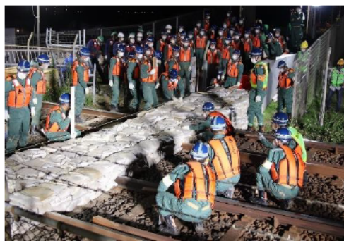
① 土のう設置
