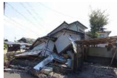
熊本地震で倒壊した新耐震基準の木造住宅
