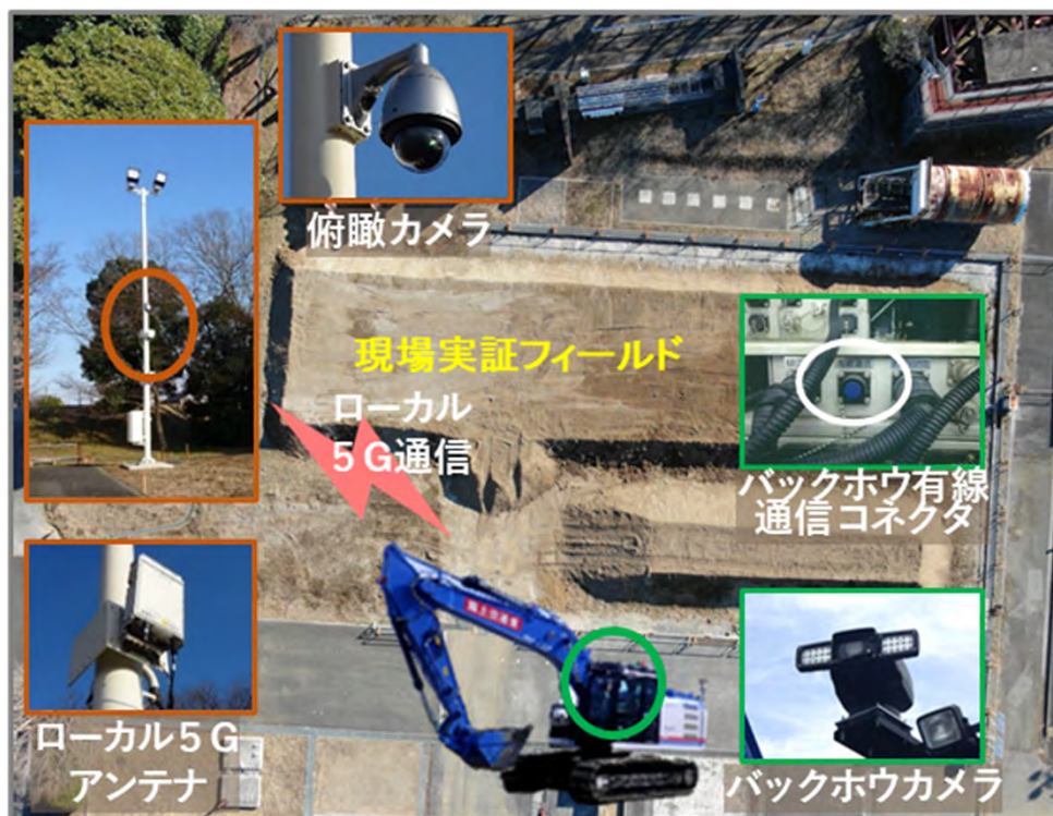
現場実証フィールド（関東技術事務所構内）
