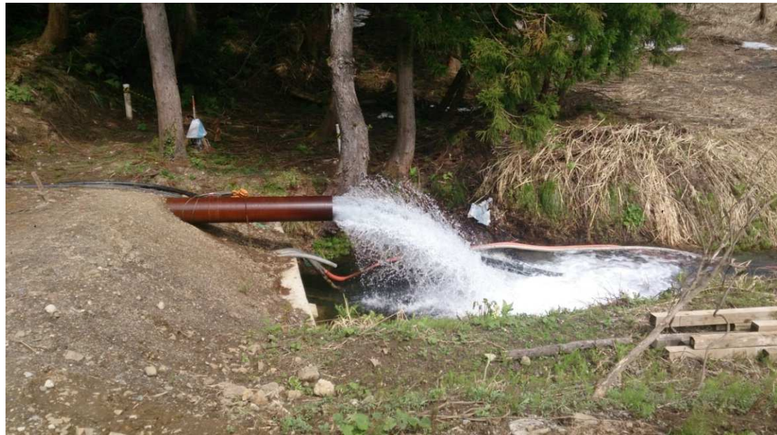
集水井内湛水1.67m
