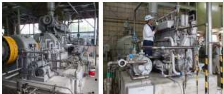
排水機場のディーゼル機関(左)と計測状況(右)
