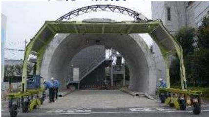
坑内を走行するフレームで点検時のコンクリート片落下から第三者を防護
