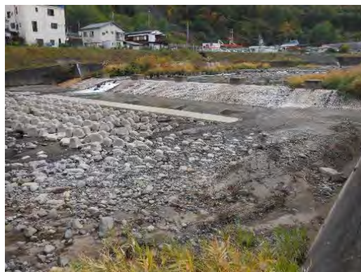
床固工イメージ(三原第二床固工)
