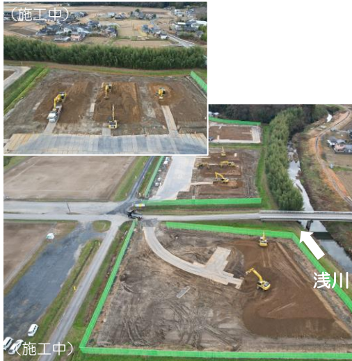
R3久慈川土砂改良(その1)工事 (株式会社杉原建設)
