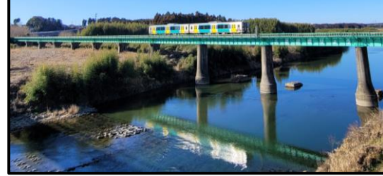
幸久歩道橋より水郡線太田支線久慈川橋梁
