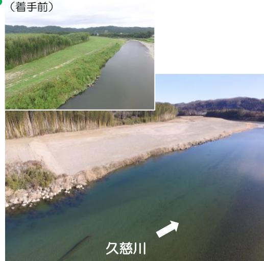
R3久慈川左岸小貫地先河道掘削工事 (樋口土木株式会社)
