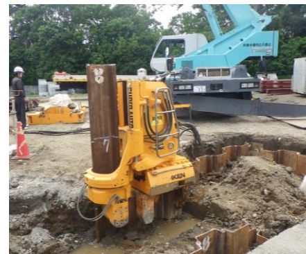
サイレントパイラー
