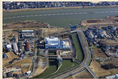
▲八潮排水機場
