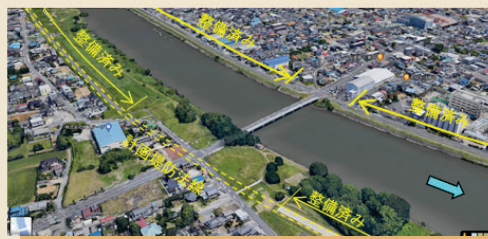
▲八条橋周辺の状況
