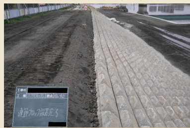
▲浸透・侵食対策
