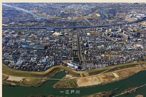
▲三郷放水路と三郷排水機場
