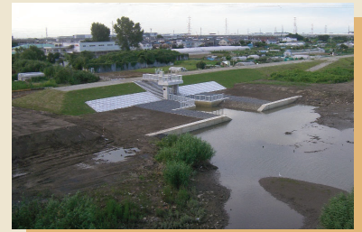
▲伊勢野排水樋管
