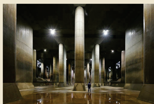
▲首都圏外郭放水路（調圧水槽）
