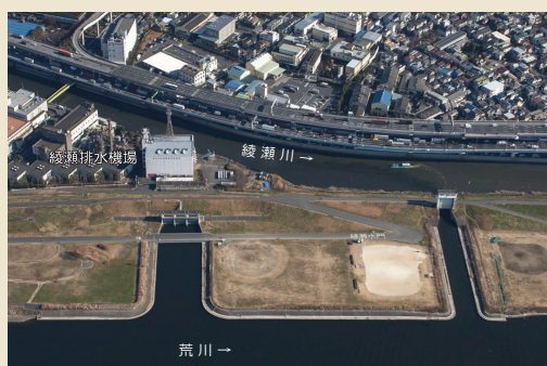
▲綾瀬排水機場
