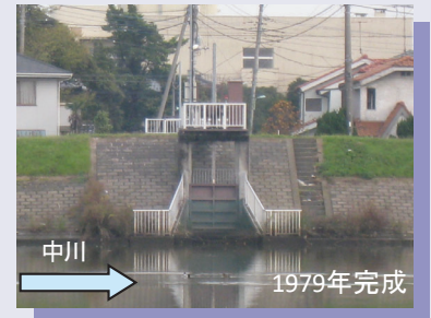
▲中川：彦野排水樋管
