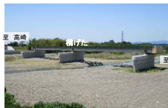
神流川橋の状況
