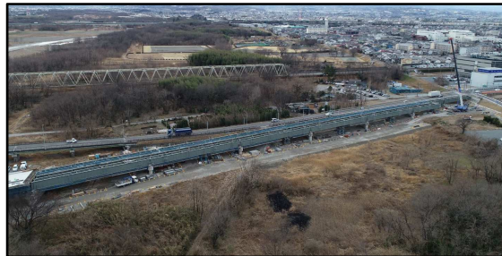
●架設工 2月24日に上り線架設作業が完了しました。(神流川下流より)
