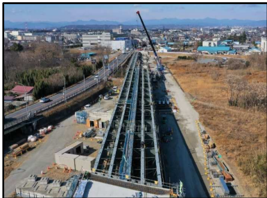
●架設工 鋼桁架設状況(さいたま方面より)
