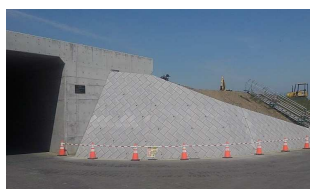
【写真②】ブロック積 施工中
