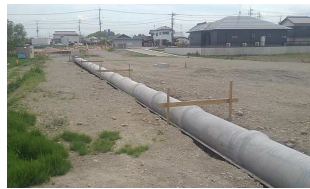
【写真③】排水構造物 施工中
