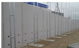
【写真①】L型擁壁 施工中
