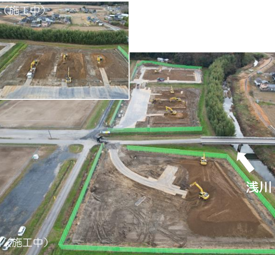
R3久慈川土砂改良(その1)工事 (株式会社杉原建設)
