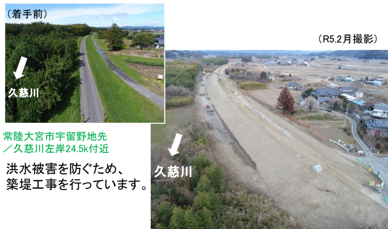
R3久慈川左岸宇留野地先築堤工事／増子建設(株)
