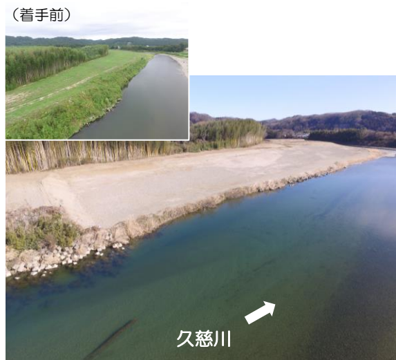
R3久慈川左岸小貫地先河道掘削工事 (樋口土木株式会社)
