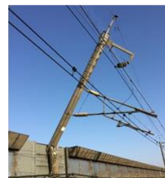
電柱の折損
