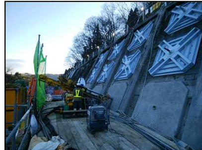
法面アンカー工施工状況(R5.1.12)
