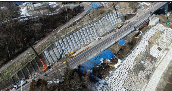
施工状況 ドローン撮影(R5.2.17)
