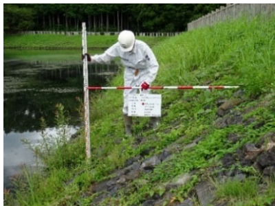
管理者によるため池の点検
