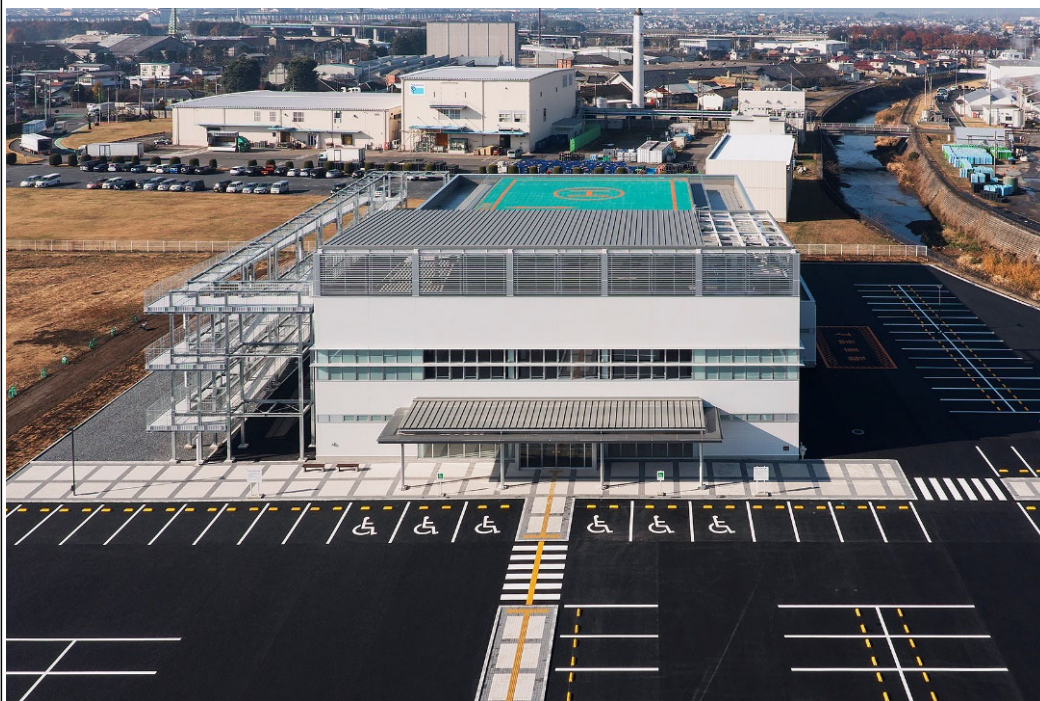
新町防災アリーナ（完成後）
