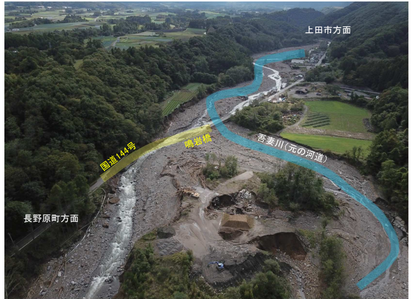
被災後の状況
